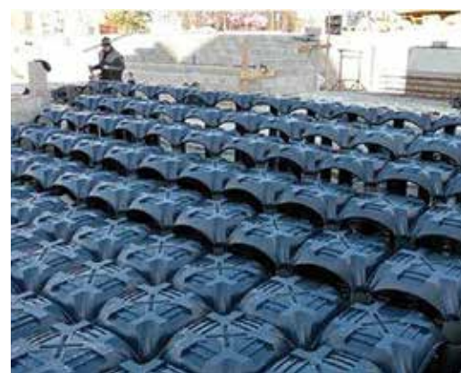
Деталь укладки опалубки
